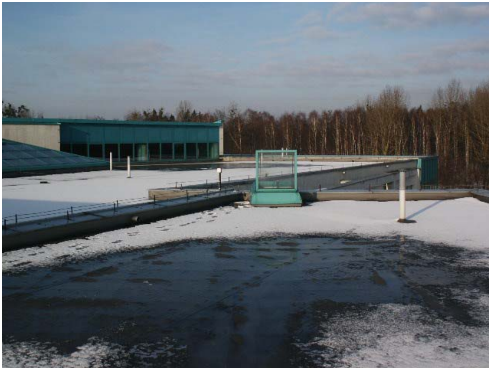
Dach części biurowo-gastronomicznej obiektu
