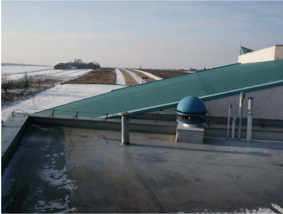
Dach hali basenów – nachylenie w kierunku południowym
